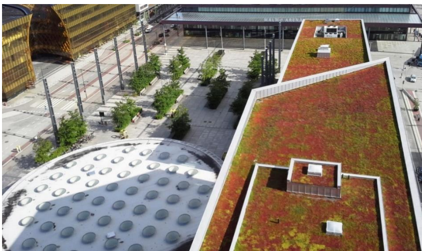
Figur 38 Exempelbild av ett sedumtak. Bild från Veg Tech (Veg Tech, 2020).
